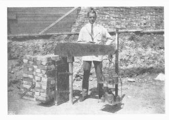
Abb. 2. Neuer Kegeldruck-Apparat für Bodenprüfung im Betrieb.
