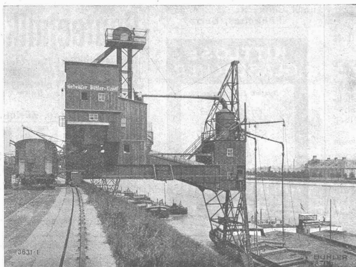
Pneumatischer Getreideheber, ausgeführt von Gebrüder Bühler, für eine Stundenleistung von 70 bis 80,000 kg Weizen, geliefert für das Schiff-fahrtsamt des Kantons Basel-Stadt für den Rheinhafen Basel-St. Johann
