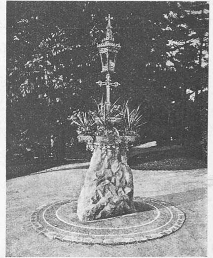
Park-Kandelaber mit Blumensockel in Hamburg. Aus J. Stübben: „Der Städtebau“. (Stark verkleinert.)
