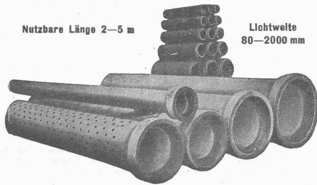
**Armierte Betonröhren**für Turbinen- und Trinkwasserleitungen, Bewässerungsanlagen,
