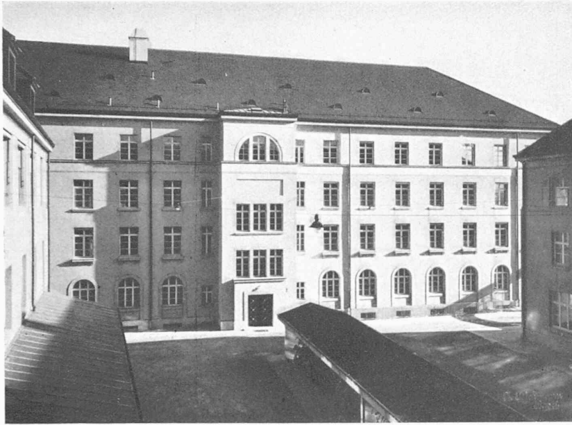
Abb. 7. Hoffront des Hauptgebäudes. (Sämtliche photographischen Aufnahmen sind von A. Teichmann, Basel.)
