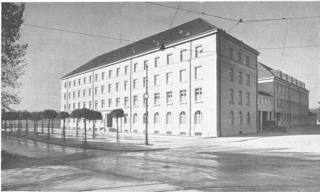
DAS VERWALTUNGSGEBÄUDE DES ELEKTRIZITÄTSWERKS BASEL
