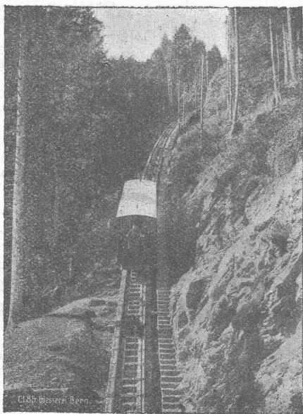
Seilbahn Niesen, I. Sektion, maximale Steigung 66%.
