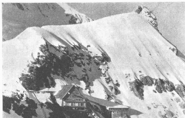
Gletscherwasser während des Druckes mit «SIKA» gedichtet und mit «Anfifrosto» betoniert
