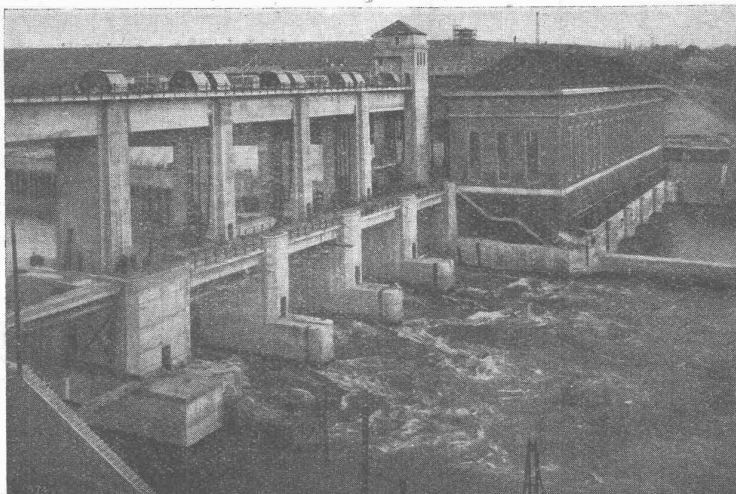
Rhone-Kraftwerk Chancy-Pougny — Wehr
