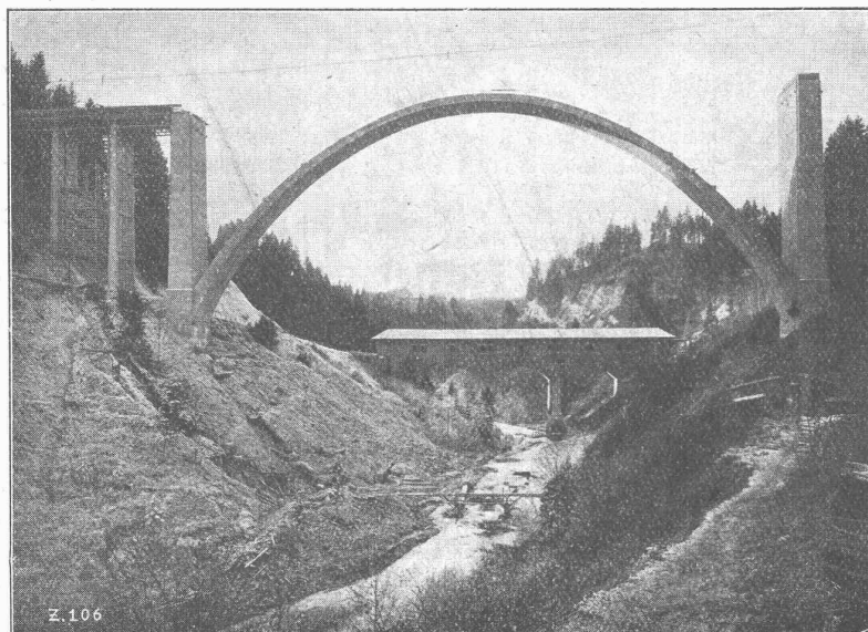
Hundwilertobelbrücke bei Waldstatt (Kt. Appenzell A.-Rh.) Eisenbetonbogen von 105 m Spannweite (Aufnahme vom 27. Dezember 1924)
