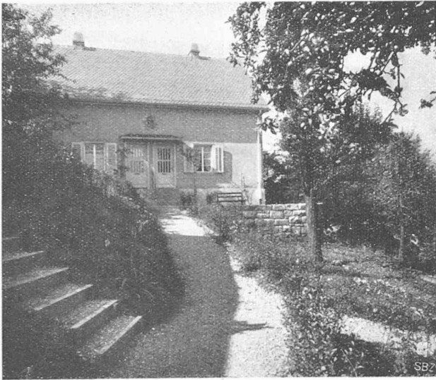
Abb. 7. Haus I aus Nordost.
