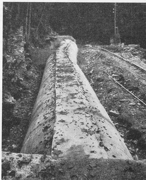
Abb. 5. Das fertige Eisenbeton-Druckrohr, noch unüberdeckt.
