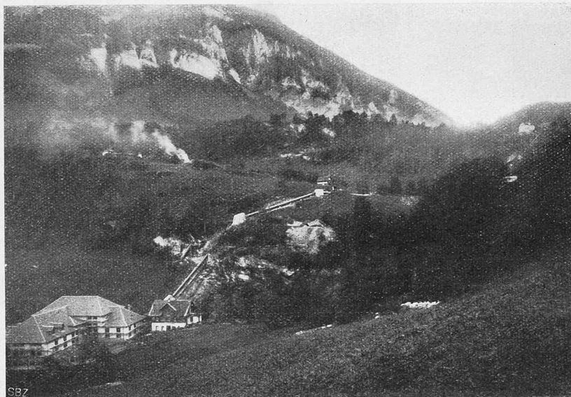
Abb. 3. Rohrleitung und Maschinenhaus des Lungernsee-Kraftwerks, oberhalb Giswil.
