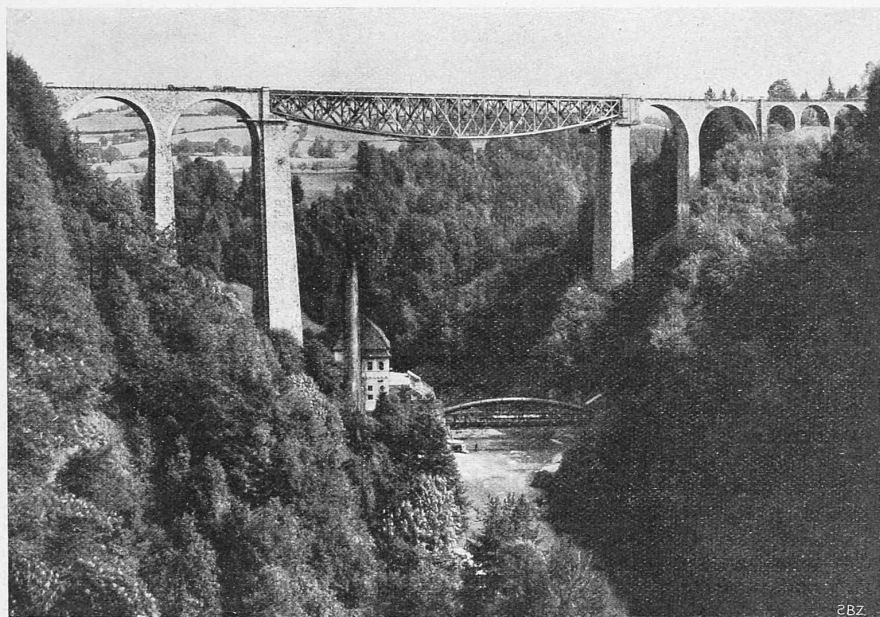
Abb. 8. Gesamtbild mit der Verspannvorrichtung am Hauptpfeiler V, Seite Herisau.
