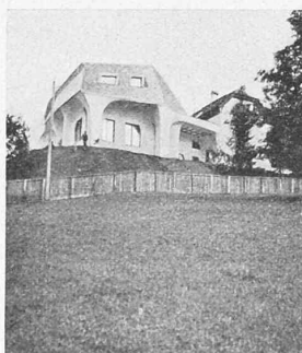
Abb. 18. „Anbau“ aus NW.
