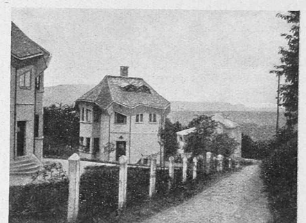
Abb. 14. Doppel-Wohnhaus u. Atelier (im Hintergrund).
