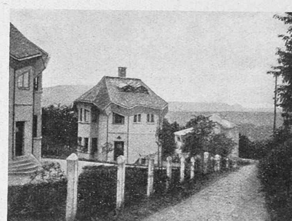
Abb. 14. Doppel-Wohnhaus u. Atelier (im Hintergrund).
