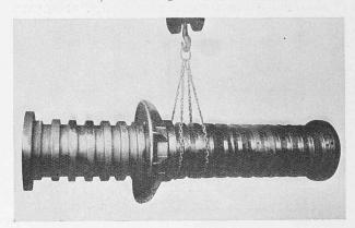
Abb. 3. Bandagiertes Rohr mit Verankerungsring (vergl. Abb. 2).
