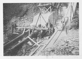
Abb. 2. Fixpunkt mit bandagierten Rohren und Verankerung.
