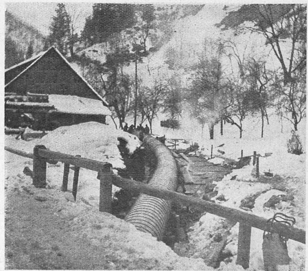
Abb. 9. Kont. Holzrohrleitung in Steyr, 900 mm Durchm., 190 m lang.
