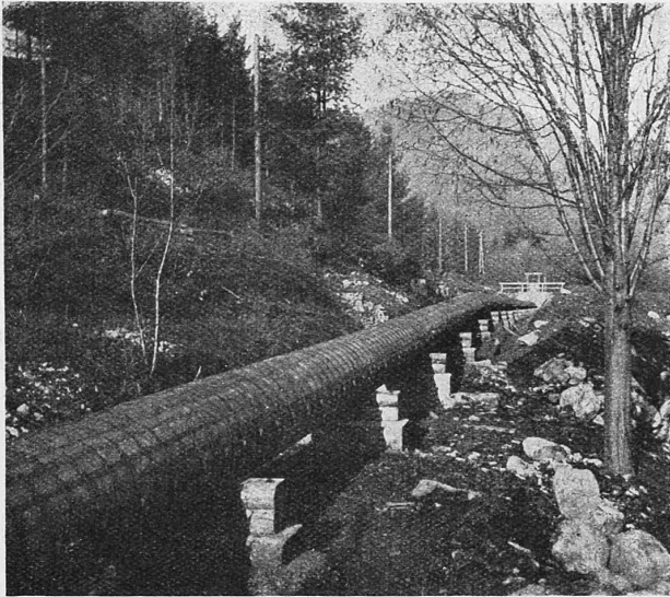
Abb. 7 und 8. Kontinuierliche Holzrohrleitung, 700 mm Durchmesser, 174 m lang, der Gutsverwaltung Schloss Prankh, Fentsch (Steiermark).
