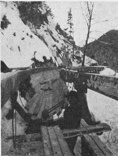
Abb. 1. Holztransport-Rinne, 1300 mm Durchm., 7200 m lang, in Steyring (Oberösterreich), in kontinuierlicher Bauweise.
