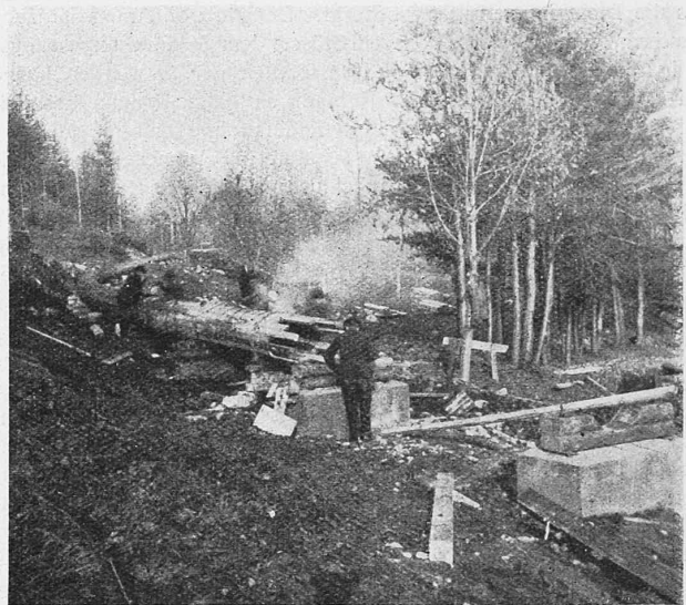
Abb. 7 und 8. Kontinuierliche Holzrohrleitung, 700 mm Durchmesser, 174 m lang, der Gutsverwaltung Schloss Prankh, Fentsch (Steiermark).
