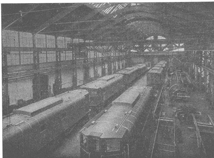
Lokomotiv-Montagehalle mit elektrischen Lokomotiven für Südafrika
