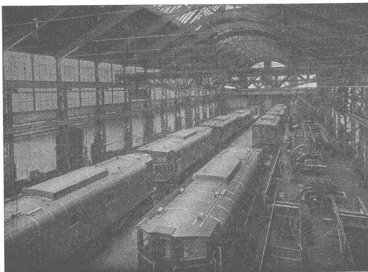
Lokomotiv-Montagehalle mit elektrischen Lokomotiven für Südafrika
