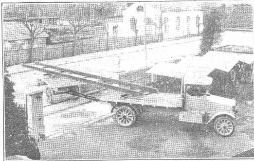
Berna 5-Tonnen mit Anhänger für Betoneisentransport
