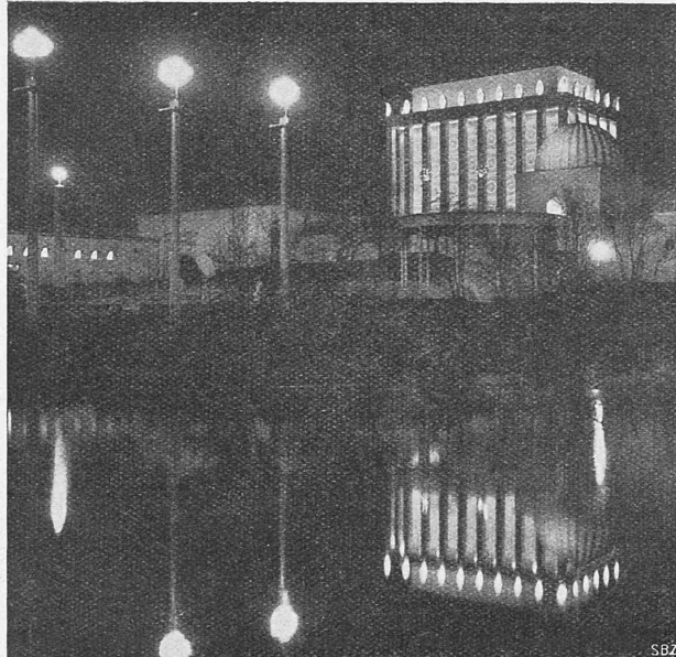
Abb. 9 und 10. Beleuchtungs-Effekte auf der Göteborger Jubiläums-Ausstellung 1923. Auf den Säulen offene, etwa anderthalb Meter hohe, gelbrote Gasflammen (Fackeln), Minarets mit Reflektoren beleuchtet, Minneshalle mit Lampen an der Innenfläche der Säulen und Reflexbeleuchtung der Akroterien.
