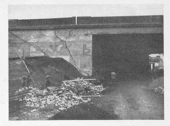
Abb. 1. Setzung der Flügelmauern bei einer Wegunterführung. Zum Artikel "Bauerfahrungen im Moor".
