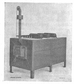
Elektrischer Glühofen Bauart Brown Boveri Nutzbarer Glühraum 1800 × 500 × 300 mm
