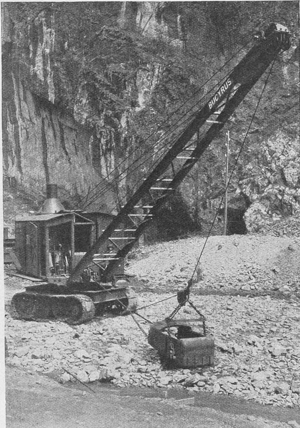
Abb. 5. Auf Raupen montierter Zugseilbagger beim Fundamentaushub der Staumauer im Schräh (5. V. 1922).
