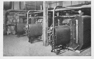
Abb. 26 und 27. Sulzersche Oelfeuerungsanlagen mit Vorfeuerung im Volkshaus am Helvetiaplatz und im Münzhof in Zürich.
