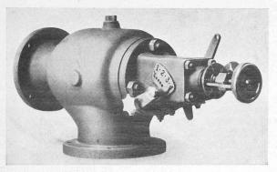
Abb. 25. Oelbrenner Bauart Sulzer für grosse Leistungen.
