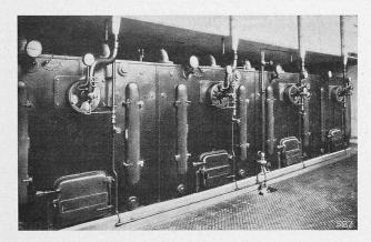
Abb. 28. Sulzersche Oelfeuerungsanlage ohne Vorfeuerung in der E.T.H, Zürich. Vier Kessel zu je 48,8 m² Heizfläche; Luftdruck 150 mm WS;
