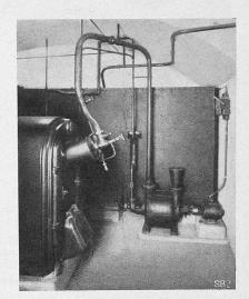
Abb. 25. Kleiner Zentralheizungskessel mit normaler Sulzer'scher Oelfeuerungsanlage in Firma Fischbacher & Cie., St. Gallen. Heizfläche 10,8 m²; Brennerleistung 10 kg/h; Luftdruck 350 mm WS; Motorleistung 0,8 PS.
