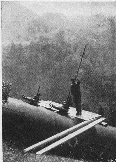
Abb. 3. Messtation für Flügel-Wassermessungen entspr. Abb. 2 auf zwei nebeneinanderliegenden Druckrohrleitungen von je 1801 mm Lichtweite.
