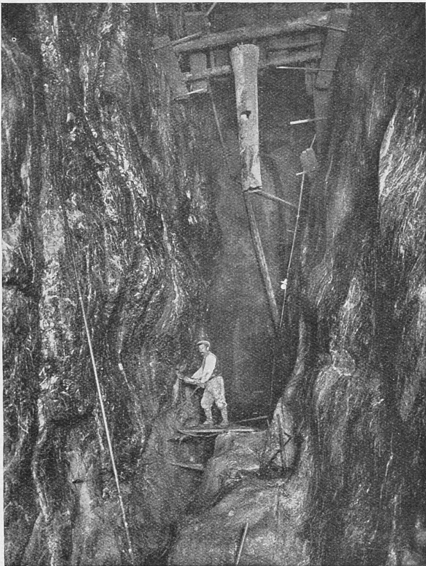
Abb. 5. Blick talwärts von 36 m talwärts der seeseitigen Mauerflucht.
