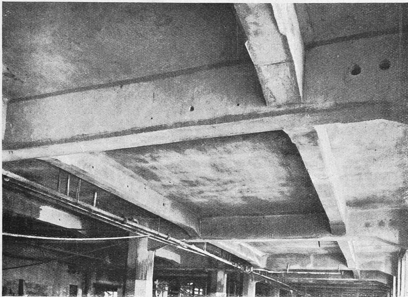
Abb. 5. Wiederhergestellte Unterzüge und Decken der Sarotti-Fabrik.
