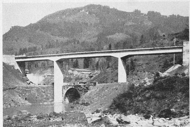
Abb. 2. Ansicht vor Füllung des Rempen-Beckens. (Unter der neuen die gewölbte Brücke der alten Strasse.)
