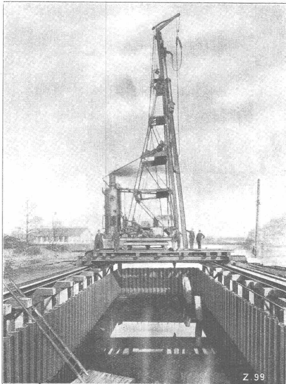
Röthlbrücke Solothurn (Ausführung in Gemeinschaftsunternehmung) Fundierung des Flusspfeilers
