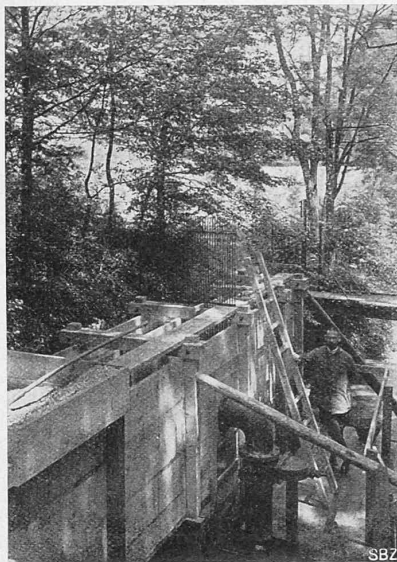
Abb. 12. Entsander-Versuchsmodell. Ansicht von oben.
