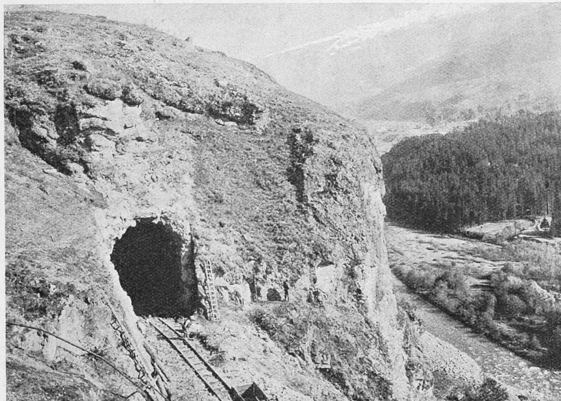
Abb. 20. Kehrabstieg der Fleimstalbahn zum Avisio (in der Tiefe rechts). Portalarterweiterung des Cavalese-Tunnel in Quarzporphyr.
