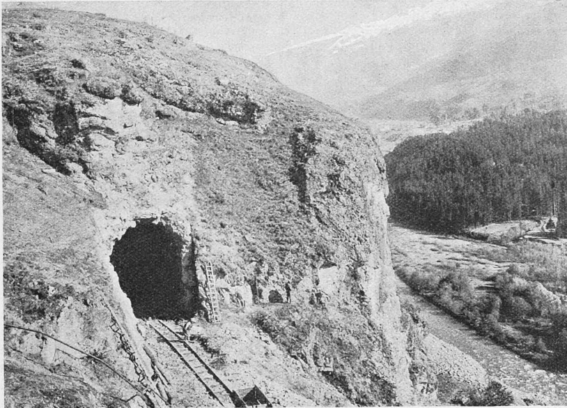
Abb. 20. Kehrabstieg der Fleimstalbahn zum Avisio (in der Tiefe rechts). Portalerweiterung des Cavalese-Tunnel in Quarzporphyr.
