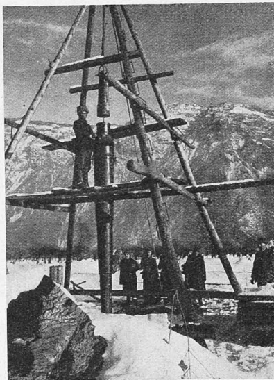
Abb. 25. Pilotierung im Gelände des Anschlussbahnhofs Auer.
