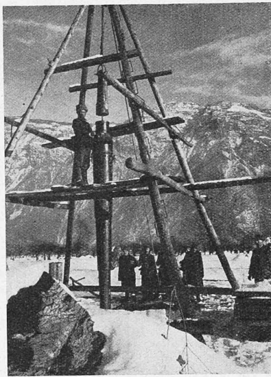
Abb. 25. Pilotierung im Gelände des Anschlussbahnhofs Auer.
