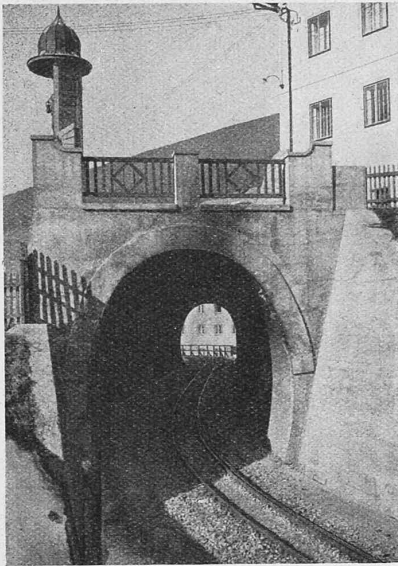
Abb. 10. Tunnel bei St. Ulrich (Grödenbahn).
