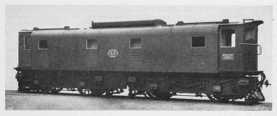
Abb. 1. B-B-Lokomotive der Südafrikanischen Staatsbahnen, ausgerüstet mit vier Gleichstrom-Motoren von je 300 PS. Mechanischer Teil der Schweizer. Lokomotivfabrik Winterthur, elektrischer Teil der Metropolitan-Vickers Electrical Co.
