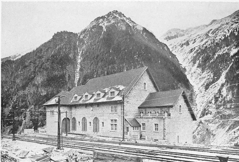
HÖCHBAUTEN DER UNTERWERKE DER ELEKTRIFIZIERTEN GOTTHARDSTRECKE DER S. B. B.
