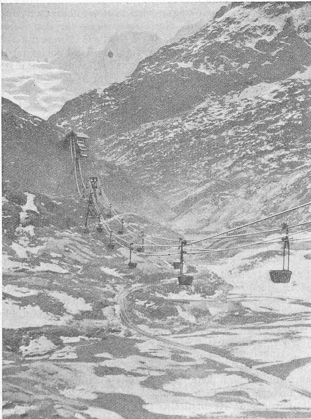
Abb. 15. Luftseilbahn G-F zur Beförderung von Sand und Kies von der Kiesaufbereitungs- nach der Betonzubereitungs-Anlage.
