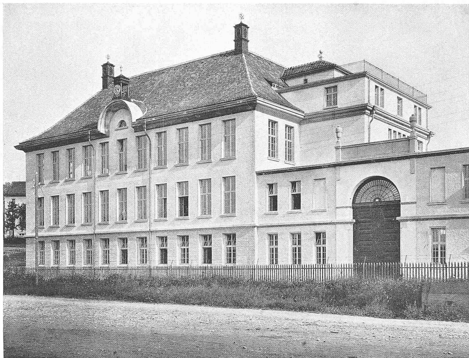
FABRIKNEUBAU HOCHULI & CIE., SAFENWIL
