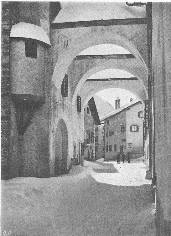
Verbindungsbögen über die Hauptstrasse zwischen Turm (links) und unterem Plantahaus. Blick von Ost nach West (talaufwärts.)
