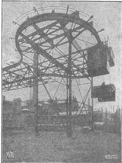
Kohlenförderanlage Kraftwerk Bingen der Kreuzbacher Elektrizitätswerke
