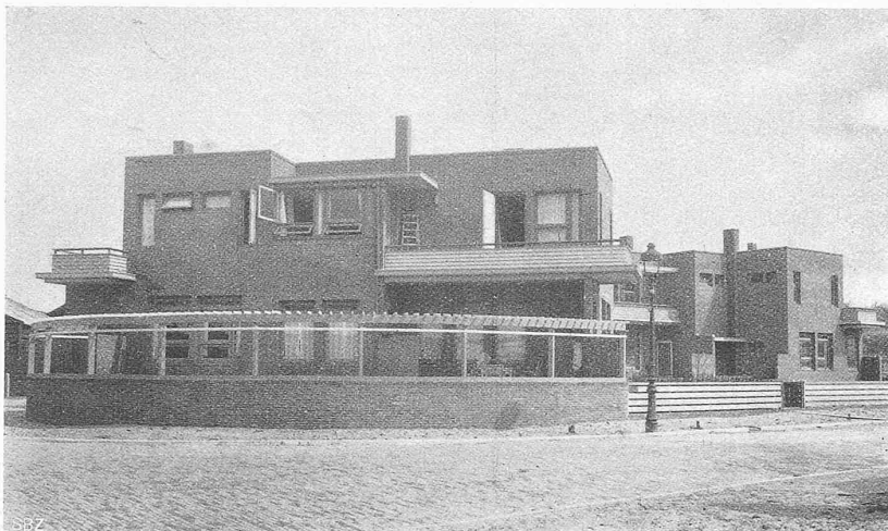
Abb. 15. Einfamilienhaus-Gruppe im Haag. Arch. B. Bijvoet und J. Duiker. An Stelle der Fassaden (-Strassenwände) treten die kubischen Elemente des Baues. Stark räumliche Wirkung.
