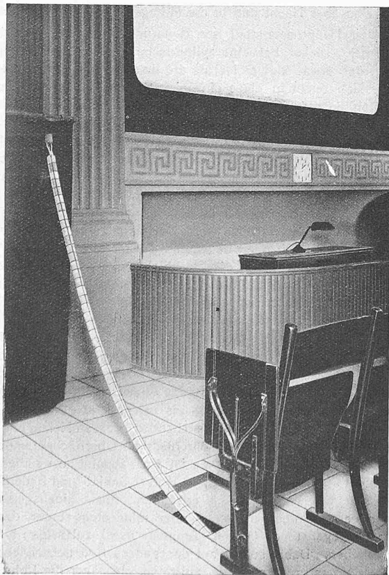
Abb. 5. Elektrische Fussbodenheizung in einem Lichtspieltheater. (Der biegsame Heizkörper ist aus seinem Kanal herausgezogen.)
