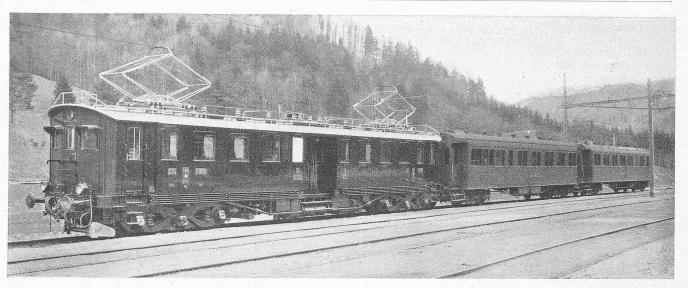
Abb. 2. 15 kV Einphasenstrom-Motorwagen Typ Ce 4/6 der S. B. B. Zugskomposition bei der Eröffnungsfahrt der Strecke Zürich-Zug am 5. März 1923.
