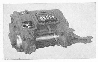
Abb. 8. Einphasenstrom-Triebmotor von 200 PS Stundenleistung der Ce 4/6 Motorwagen der Schweizer. Bundesbahnen.
