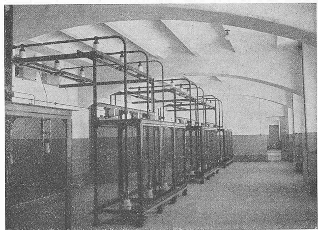
Abb. 45. Zwischendecken-Ausführung mit alten Eisenbahnschienen.
