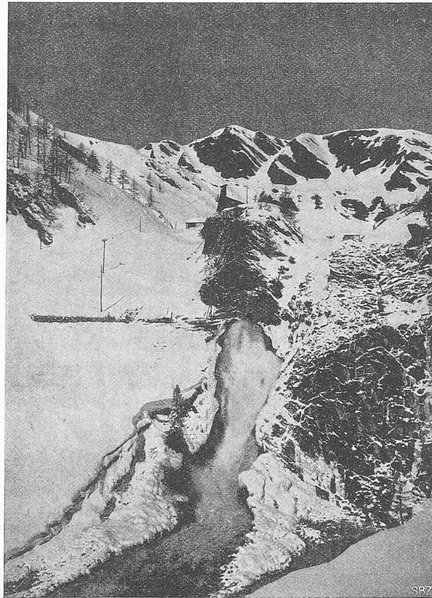
Abb. 7. Ausmündung des Grundablast-Stollens in den Fossbach (6. III. 1917).
