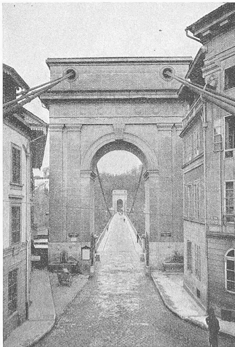
Abb. 2. Durchblick durch das stadtseitige Brücken-Portal.
