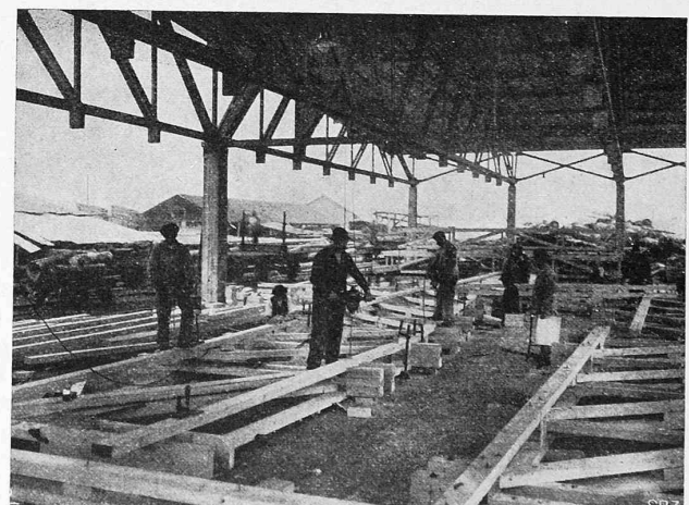
Abb. 12. Elektrisches Bohren der Konstruktionen am Abbundplatz.
