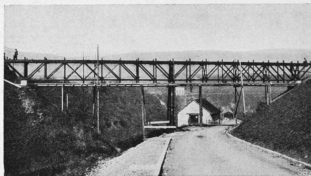
Abb. 17. Provisorische Transportbrücke von 20 + 20 Stützweite und je 2,5 m End-Auskragung; Bauplatz Chancy.
