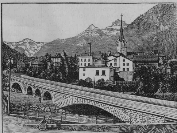
Eisenbahnbrücke ü. d. beiden Lintharme i. Schwanden
