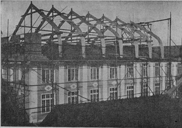
Stockwerksaufbau einer Fabrik nach Hetzer'scher Bauart.
