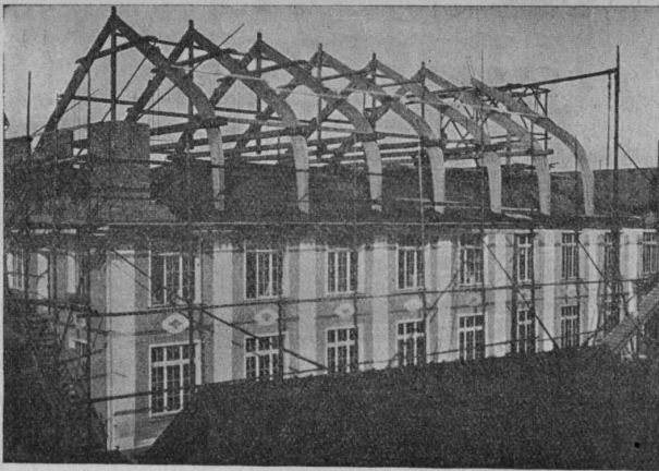
Stockwerksaufbau einer Fabrik nach Hetzer'scher Bauart.
