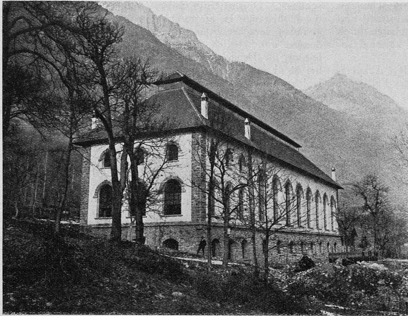
Abb. 22. Das Maschinenhaus der Wasserkraftanlage Fully, aus Süden gesehen.
