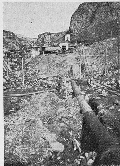
Abb. 21. Die Druckleitung Fully im Bau.
