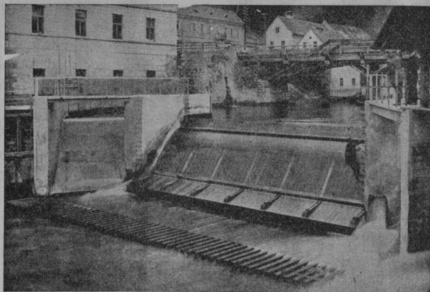
Dachwehr in der Mürz der Kabelwerke Feltens &amp; Guilleaume, Bruck a. d. Mur.
