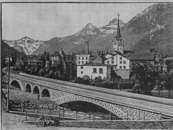
Eisenbahnbrücke ü. d. beiden Lintharme i. Schwanden
