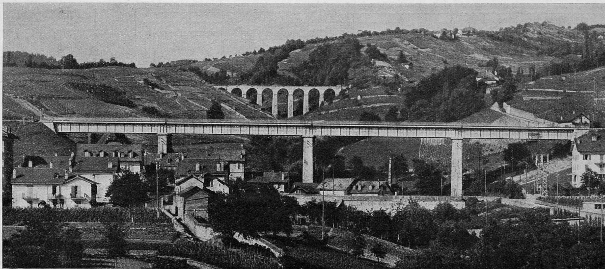
Abb. 2. Brücke der S.B.B.-Linie Lausanne-Villeneuve über die Paudèze bei Lutry (Kanton Waadt). — Stützweiten 35 m, 45,7 m, 45,7 m, 35 m. Nach dem Entwurfe von Bridel in den Jahren 1858/62 von Bonzon & Fils in Yverdon erbaut.
