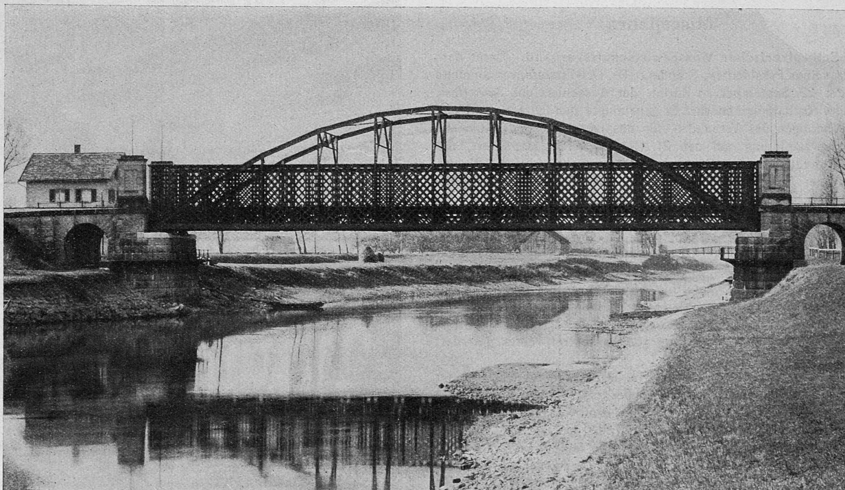
Abb. 3. Brücke der S.B.B.-Linie Zürich-Chur über den Linth-Kanal bei Weesen. — Stützweite 49,6 m. Im Jahre 1859 von Ing. G. Dollfus in Mülhausen erbaut. (1897 von der A.-G. Th. Bell & Cie. in Kriens durch einen Bogen verstärkt.)
