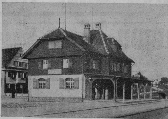
Stationsgebäude in Oberaach. Aeussere Wandverkleidung: Eternit-Geschlaufte Deckung, kupferbraun.
